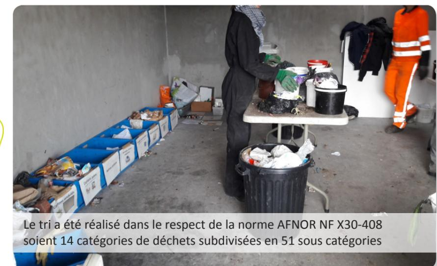
Le tri a été réalisé dans le respect de la norme AFNOR NF X30-408 soit 14 catégories de déchets subdivisées en 51 sous catégories
